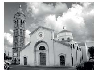
2010, dopo il recente restauro
